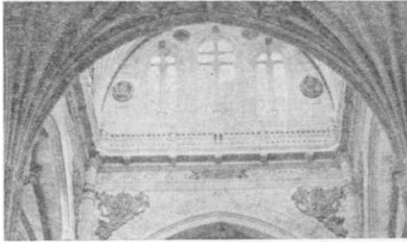
Ventanales y balaustrada del cimborrio
